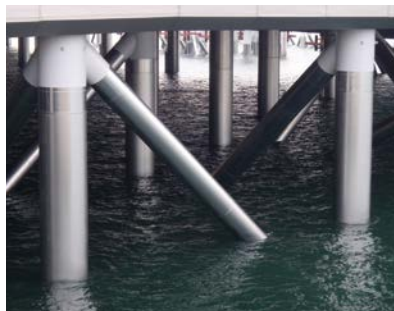
羽田空港D滑走路橋脚被覆材
