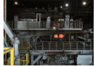
新電気炉 (E炉)
