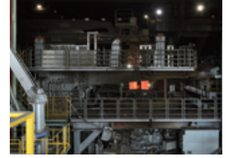
新電気炉(E炉)
