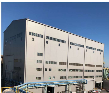
製鋼工場 新電気炉 増築建屋
