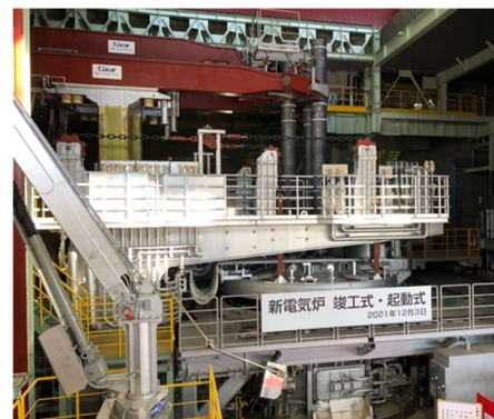
新電気炉 炉体
