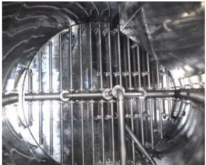
運転開始時と変わらぬ食塩スラリータンクの内部 (タンク上部から撮影)
