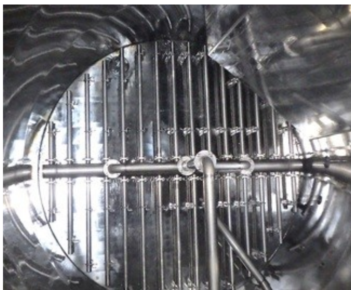
自投入运行以来一直没有变化的盐浆罐内部 （从罐上方拍摄）
