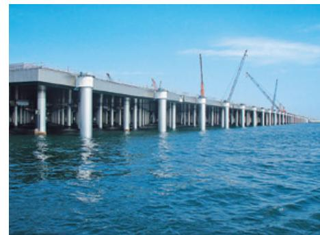
高耐食スーパーステンレス鋼の使用例 (羽田D滑走路橋脚 ©ステンレス協会)
