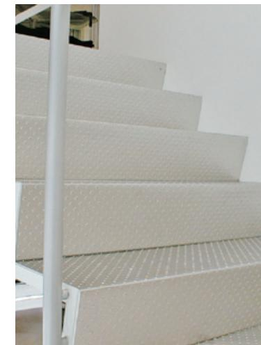
ポリカプレート (床用ステンレス鋼板)
