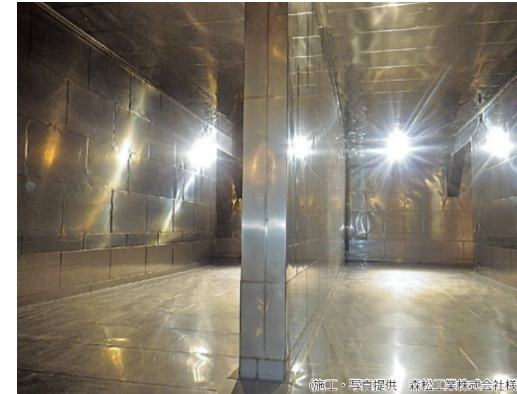
蹴上浄水場配水池内部
