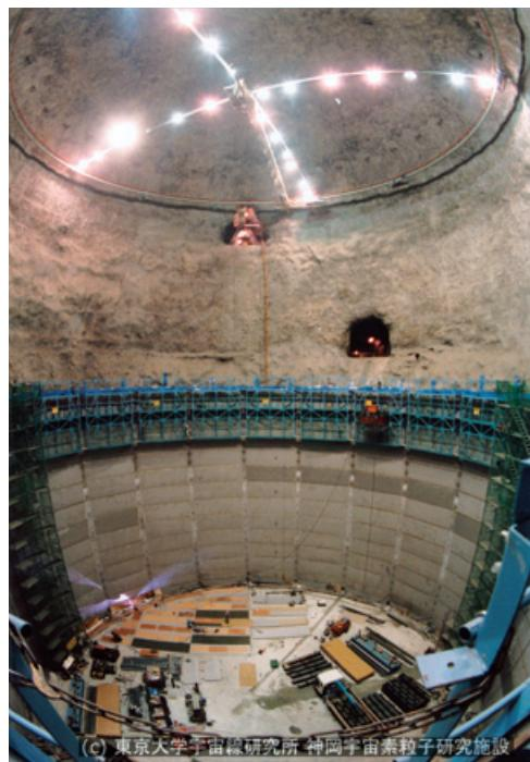
① 鉱山内の空洞にステンレス板を貼り付け中
