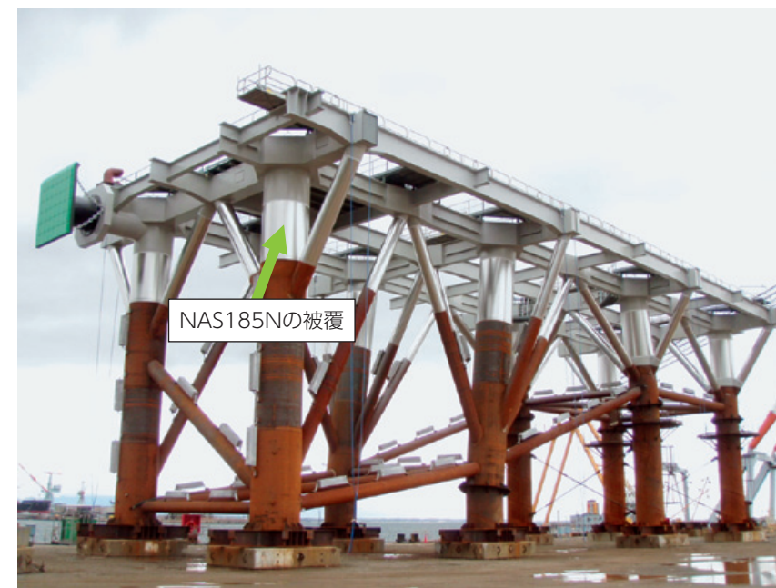
NAS185Nで被覆された海洋鋼構造物 (現地据付前)
