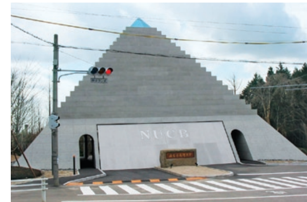
写真② 中央の「NUCB」と表示のある部分が電動門扉
