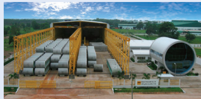
コンクリート管製造工場 (右側の大きなパイプ型構築物は工場事務所です)
