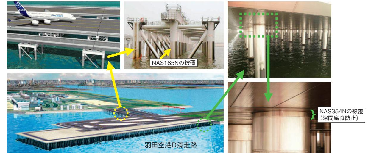
羽田空港の4本目の滑走路として2010年秋に完成が予定されているD滑走路は、多摩川の通水性と船舶の航路を確保するために、埋立と栈橋とを合わせたハイブリッド構造となっています。
