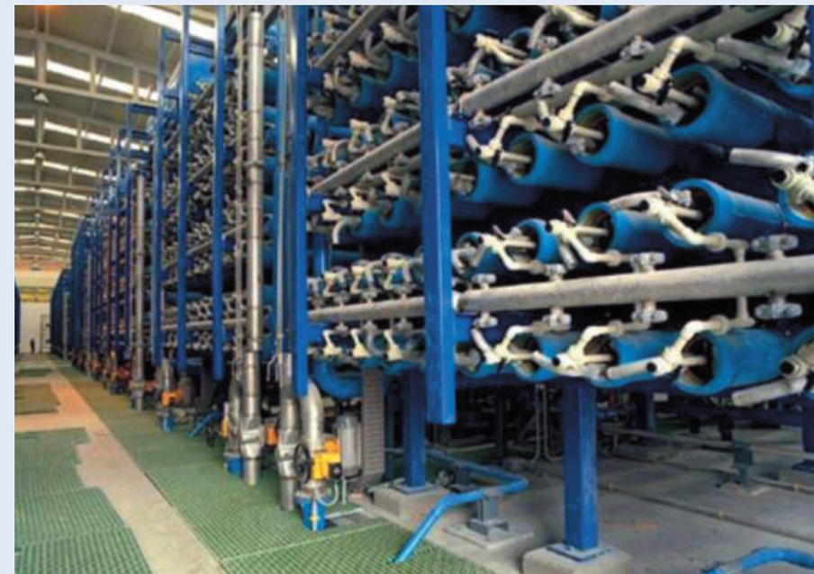
現在、主に中東地域で建設が旺盛になっている海水淡水化装置（逆浸透膜法）の素材として当社の2相ステンレス鋼（NAS329J3L）が採用されています。
