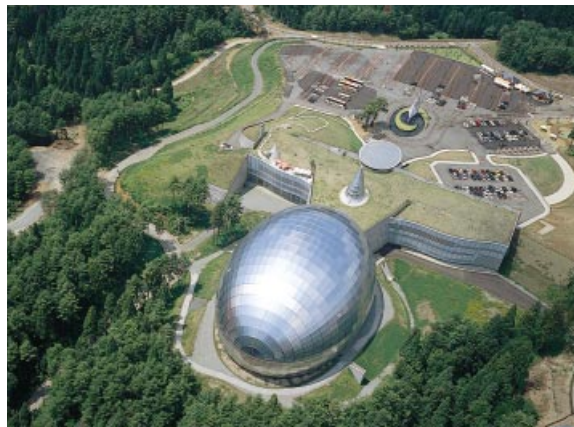
福井県立恐竜博物館(福井県勝山市) 間口約87m 高さ約39m 奥行き約58m ステンレス使用量 140t 設計者:黒川紀章建築都市設計事務所 施工者:前田建設工業㈱・西田建設㈱・大野建設工業㈱共同企業体 製作者:ヤマキ工業㈱
