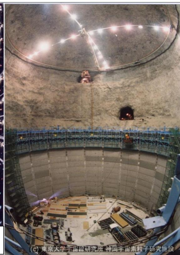
弊社の高品質なステンレス鋼NAS304は、このタンクの床材に数十トン使用され、5万トンの超純水を保持し続けています。
