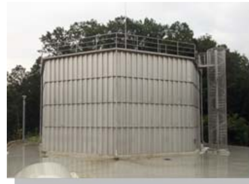
浄水場タンク
