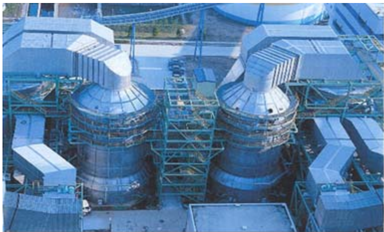
排煙脱硫装置用 (韓国向け)
