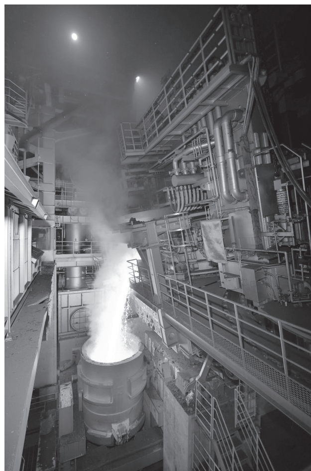
写真-2 E炉本体周り
